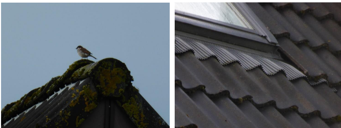
Afbeelding 4: Zingende huismussen op de woning in het plangebied. Onder de dakpannen zitten verschillende geschikte plekken voor huismussen om toegang te krijgen tot de ruimte tussen de pannen en het dakbeschoot.
