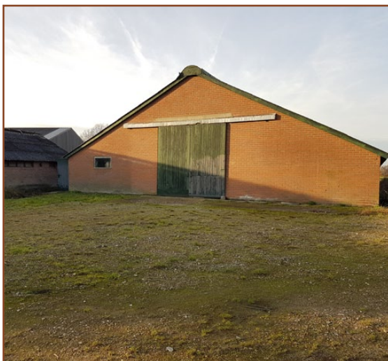
Afb. 2.3: Grote veestal, met links de kleinere veestal en op de achtergrond de kapschuur. De stal is ongeschikt voor vleermuizen en er werden geen nesten aangetroffen.
