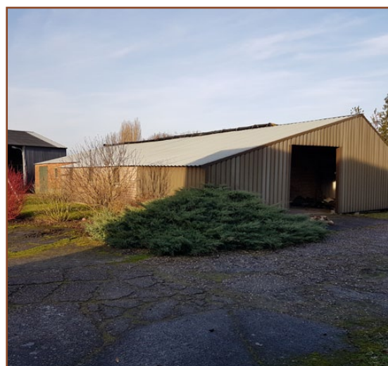
Afb. 2.6: De kleine veestal, met linksachter de kapschuur.
