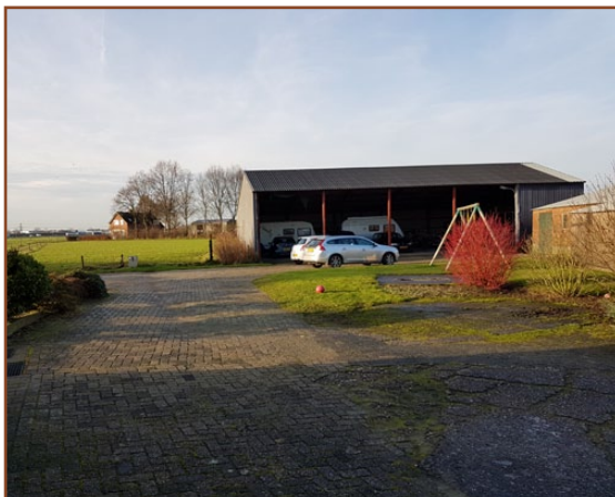
Afb. 2.1: De te slopen kapschuur gezien vanaf de bestaande woning. Ongeveer op de plek van de kapschuur wordt een houten schuur gerealiseerd.
