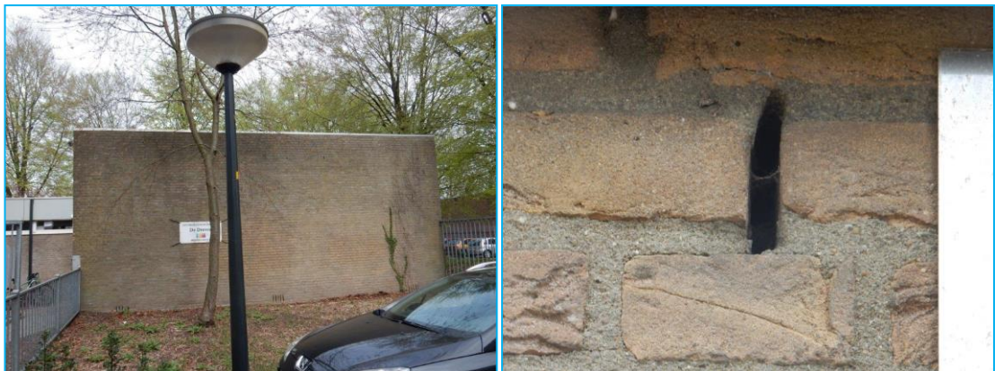
Foto's: Toegankelijke spouw door open stootvoegen.
