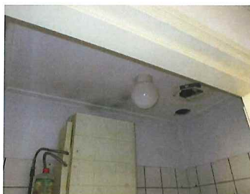
Foto 20: Plafondplaten (Abm/101): geen asbest
