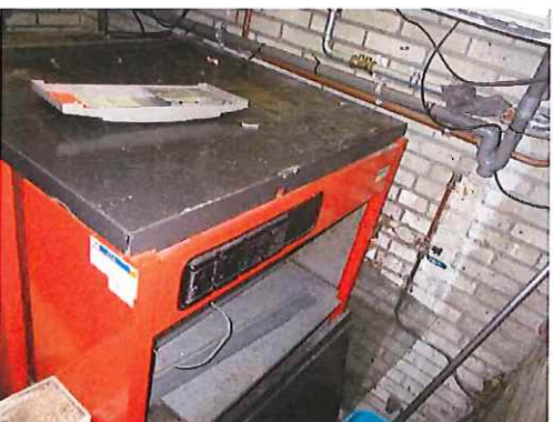
Foto 5: CV-ketel: asbestvrij
