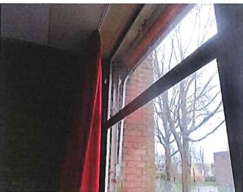
Foto 8: Beglazingskit (Abm/003): geen asbest
