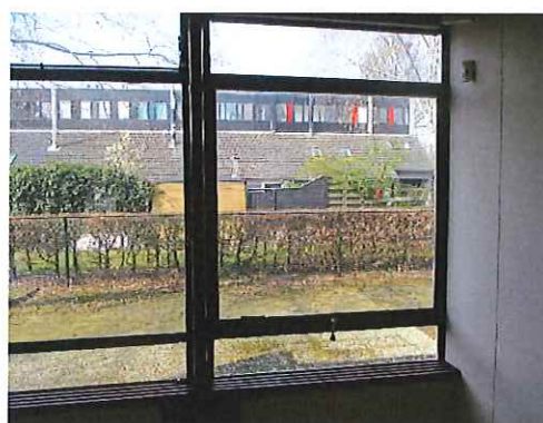
Foto 22: Beglazingskit (Abm/102): geen asbest
