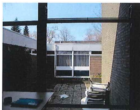
Foto 24: Beglazingskit (Abm/103): geen asbest
