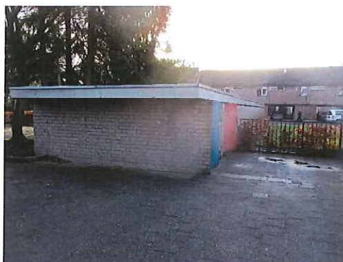
Foto 19: Schuur/fietsenstalling: geen asbest
