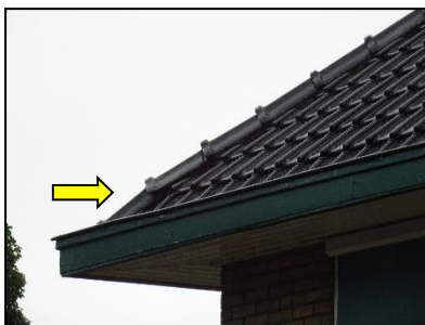
Figuur 25. Scheve dakpannen, Dorpstraat 65.
