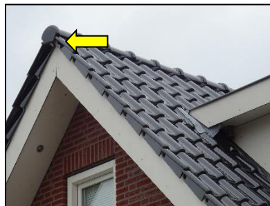
Figuur 24. Ruimtes onder de nok kunnen door gierzwaluwen benut worden.
