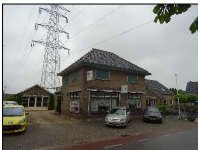
Figuur 3. (Bedrijfs)woning met schuur/garage aan de Dorpstraat 65.
