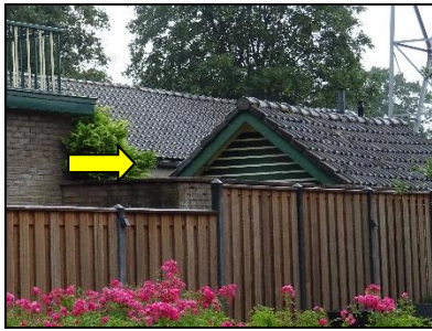
Figuur 16. Schuur met dakgoot en dakpannen Dorpstraat 65.
