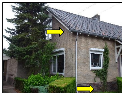
Figuur 26. Openingen in de muur en onder dakrand, Dorpstraat 94.
