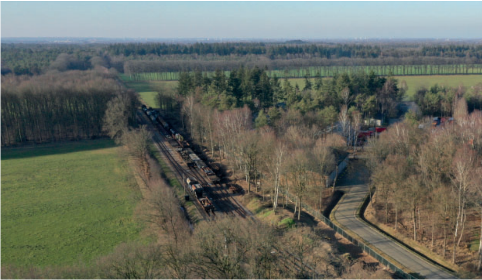
De noordwesthoek van het MOB-terrein. Bron Eelco Koppelaar
