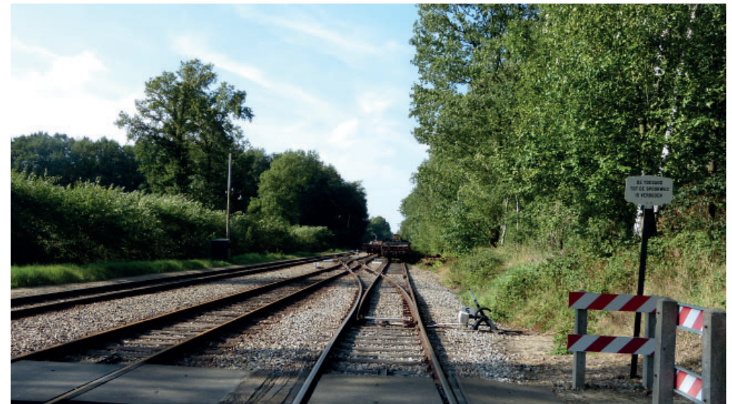
3. Halverwege het terrein, richting noorden. Na de wissels begint de locatie voor de stalling.
