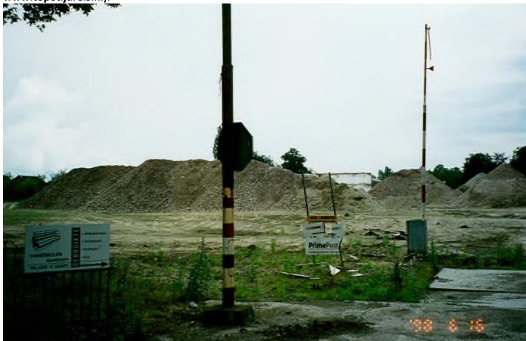
Afbeelding 11. Het terrein na sloop van de afgebrande gebouwen, gezien vanaf de Eendrachtstraat; de foto is genomen op 16 juni 1998 (bron: CODA beeldbank).
