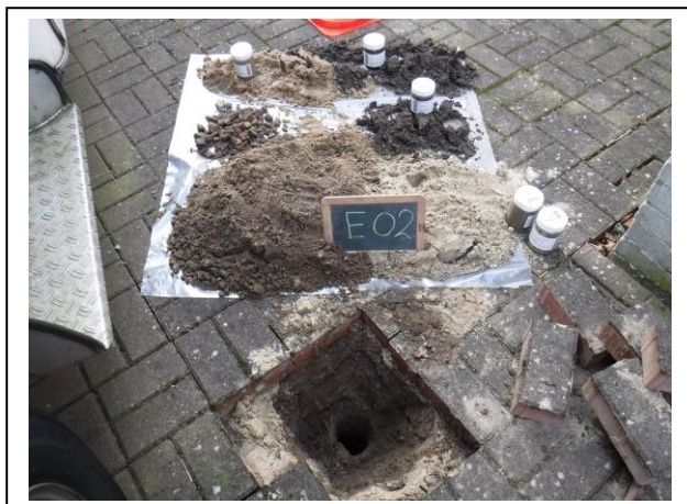
Foto: Inspectiegat E02
