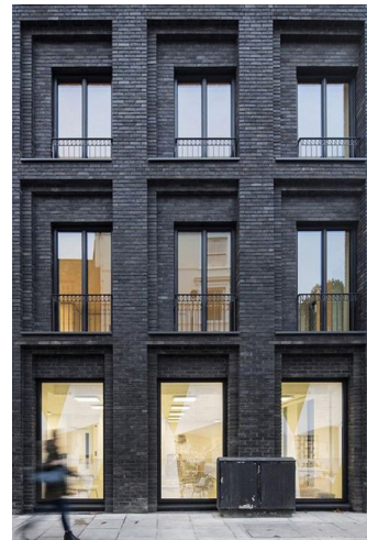
schaal in metselwerk
