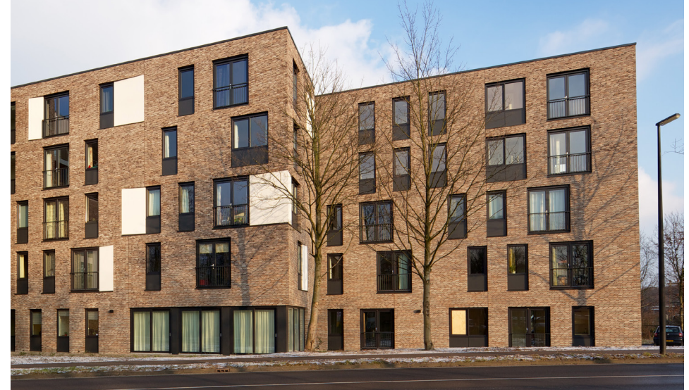
eenvoudige en functionele gevelopeningen
