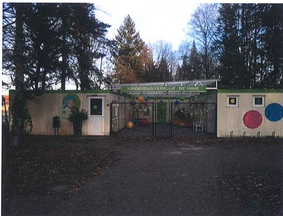
Figuur 4 Langs de Sprengentweg is tevens kinderdagverblijf. Het gebouw is niet geschikt voor vleermuizen of andere gebouwbewonende soorten.
