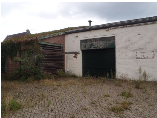
Foto 4: Linkerzijde van het gebouw aan de zuidzijde. Goed zichtbaar is de beplanking. Boven de deur zijn de smalle stootvoegen aanwezig. Rechtsboven op de foto is de TL verlichting nog zichtbaar.
