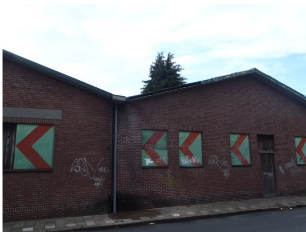
Foto 8: de oostzijde van het complex, de zijde van de Pr. Beatrixlaan. Een boeideel ontbreekt hier gedeeltelijk. Sporen van vogels of vleermuizen onder dit ontbrekende deel zijn niet aangetroffen.
