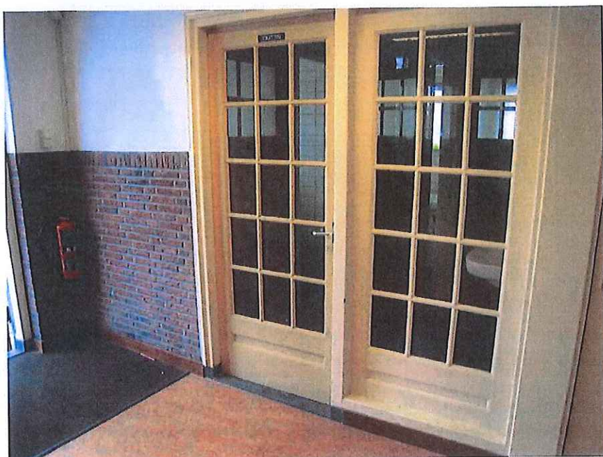
Afb. 16 Toiletsectie in het lagere bouwdeel.
