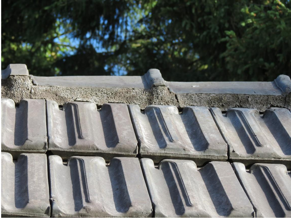
dicht gemetselde nokvorsten
