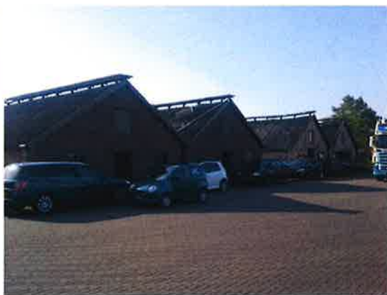
Foto 4: Nog bestaande stallen met beschadigde asbestdaken.
