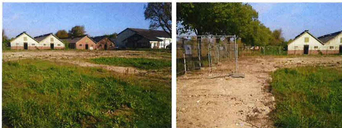
Foto 7: Overzicht gesloopte terreindeel vanaf straatzijde. Foto 8: Locatie voormalige oprit.
