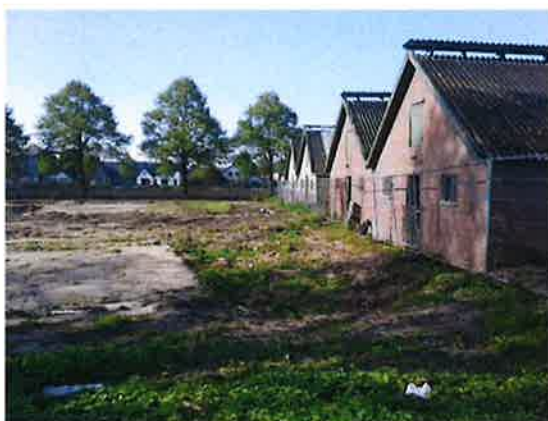
Foto 6: Grens tussen voormalige gesloopte deel van het erf en bestaande stallen, met hekwerk op de scheiding.
