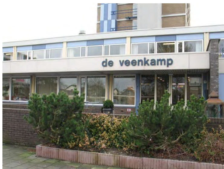
Afb. 51 en 52 Servicevleugel, noordzijde, met huidige hoofdentree en uitbouw met aula
