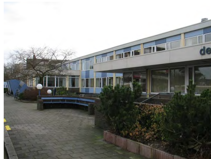
Afb. 49 en 50 Servicevleugel, van boven in oostelijke richting, en zicht op de noordgevel, richting Koninginnelaan
