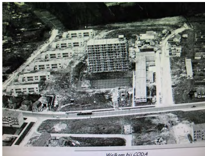
Afb. 7 en 8 Boven: bebouwing van de Nieuwe IJsbahn. Beneden: De Veenkamp in aanbouw (foto's CODA, Apeldoorn)
