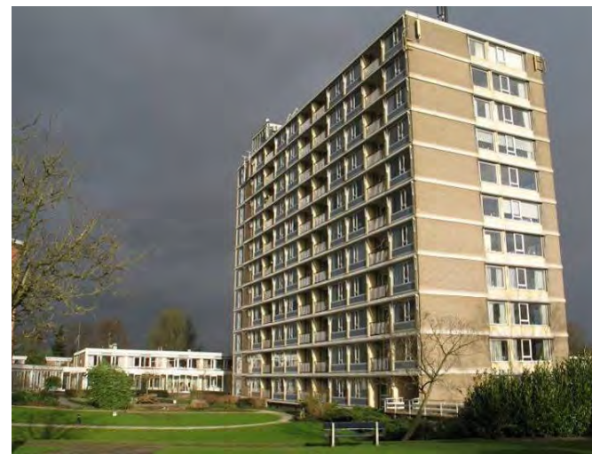
Afb. 40 Hoofdgebouw vanuit het zuiden
