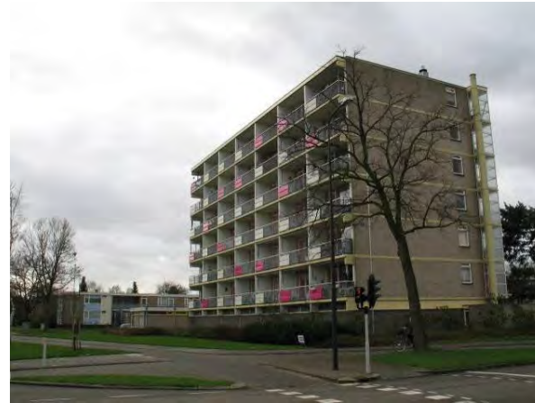
Afb. 97, 98, 99, 100 In de vrijgezellenflat (circa 1972-1974), een ontwerp van architect W. van Tijen, waren onder andere verpleegsters van de Veenkamp gehuisvest. Het gebouw heeft nog veel oorspronkelijke details behouden. Het ligt op de hoek van de Koninginnelaan en de Gemzenstraat en is hier gefotografeerd vanuit de Hoogbouw van de Veenkamp (links boven), en vervolgens vanuit het zuidoosten, het noordwesten en noordoosten. Op de foto links onder staat het kunstwerk van Harry Meek.
