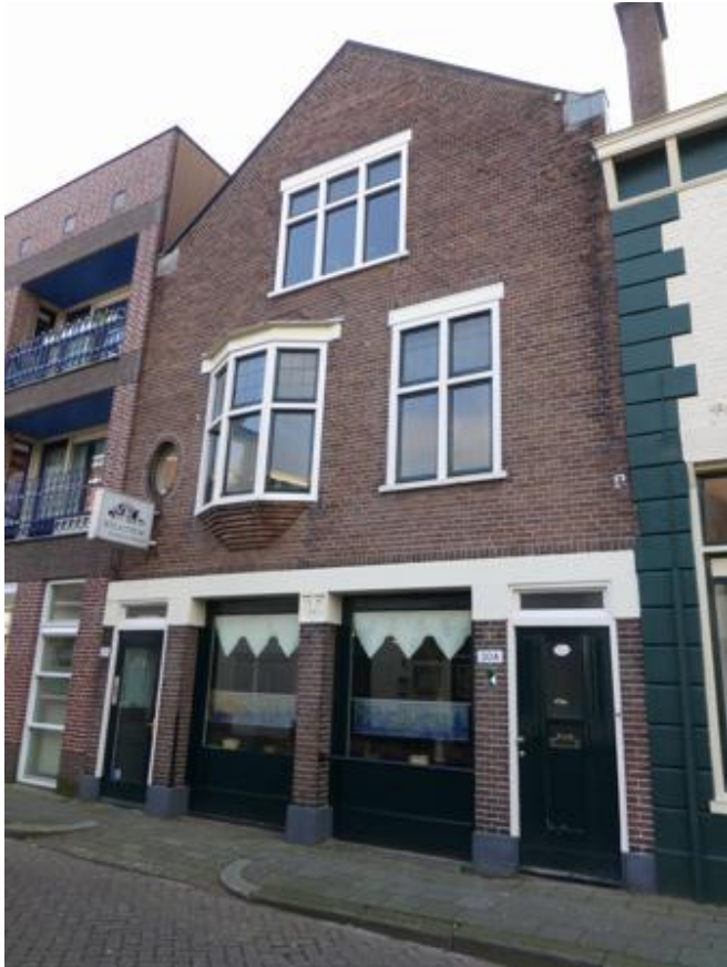
Fig. 2.9: Het pand aan de Beekstraat 30/30a (bron: Rodenburg (Bedrijfs)makelaars Apeldoorn).
