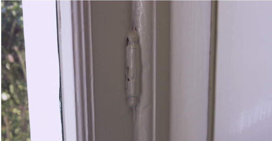
Detail van een oud scharnier met losse pen.
