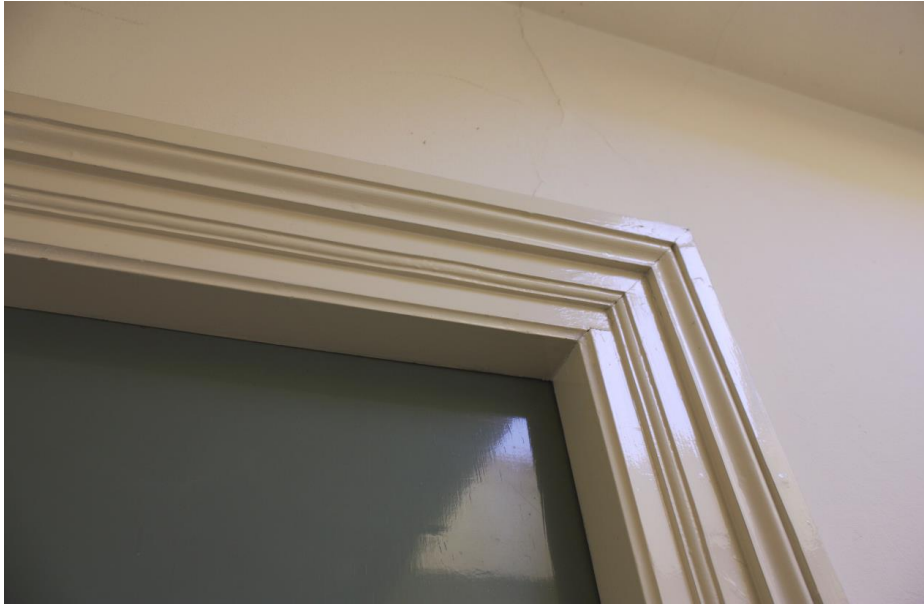
Detail van het oudere deurkozijn op de overloop op zolder. Wellicht is dit kozijn, gezien de profileringen, een overblijfsel uit de periode vóór 1909.
