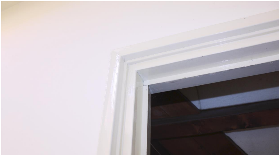
De andere doorgang op de overloop is jonger en het kozijn is veel minder geprofileerd.
