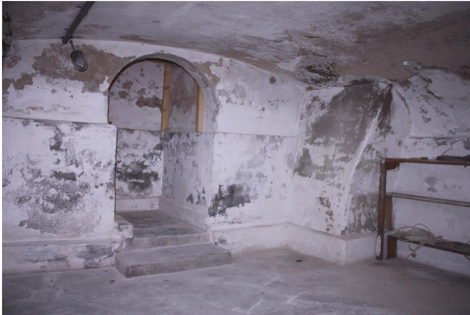
Zicht op de voorzijde van de kelder met doorgang en rechts het kanaal in de hoek.
