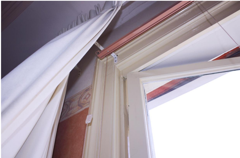
Detail van het oorspronkelijke venster in de achtergevel bij de centrale achterkamer op de verdieping.
