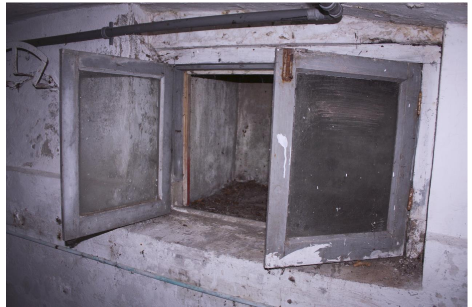
Detail van het kelderraam in de achterwand van de kelder.
