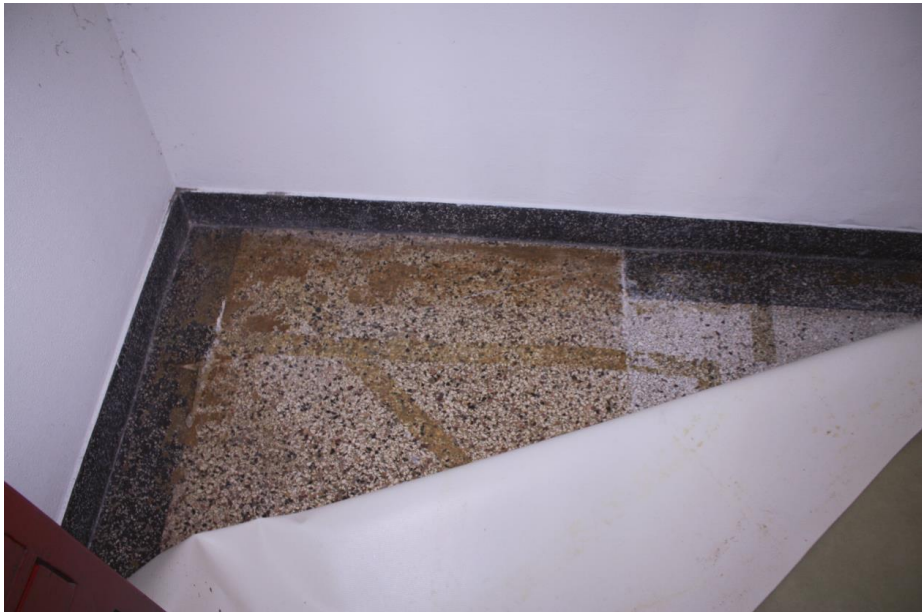
Detail van de terrazzovloer in de smalle gang. Vóór de verbouwing van 1954 liep de gang door richting de achtergevel. Na de bouw van de uitbouw is de gang ingekort en dat is nog goed zichtbaar in het patroon van de vloer.
