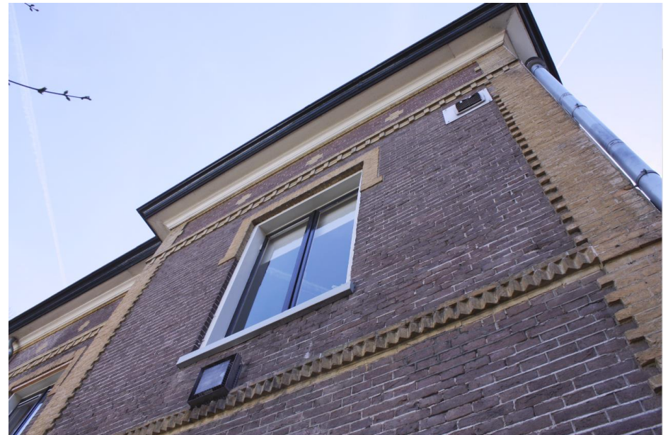
Zicht op het oorspronkelijke venster op de verdieping in de rechterzijgevel.
