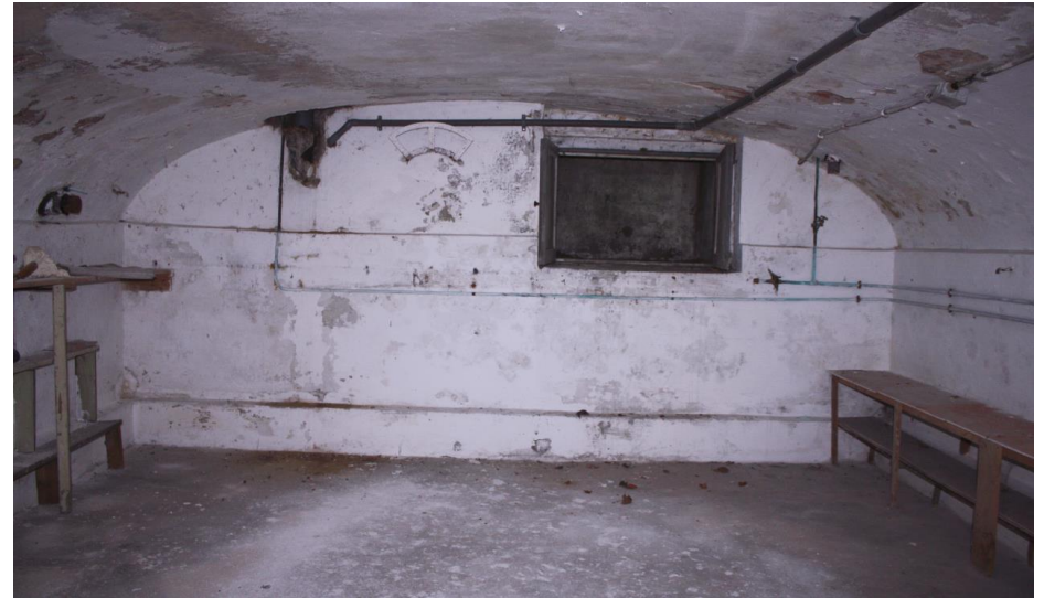
Zicht naar de achterzijde van de kelder.
