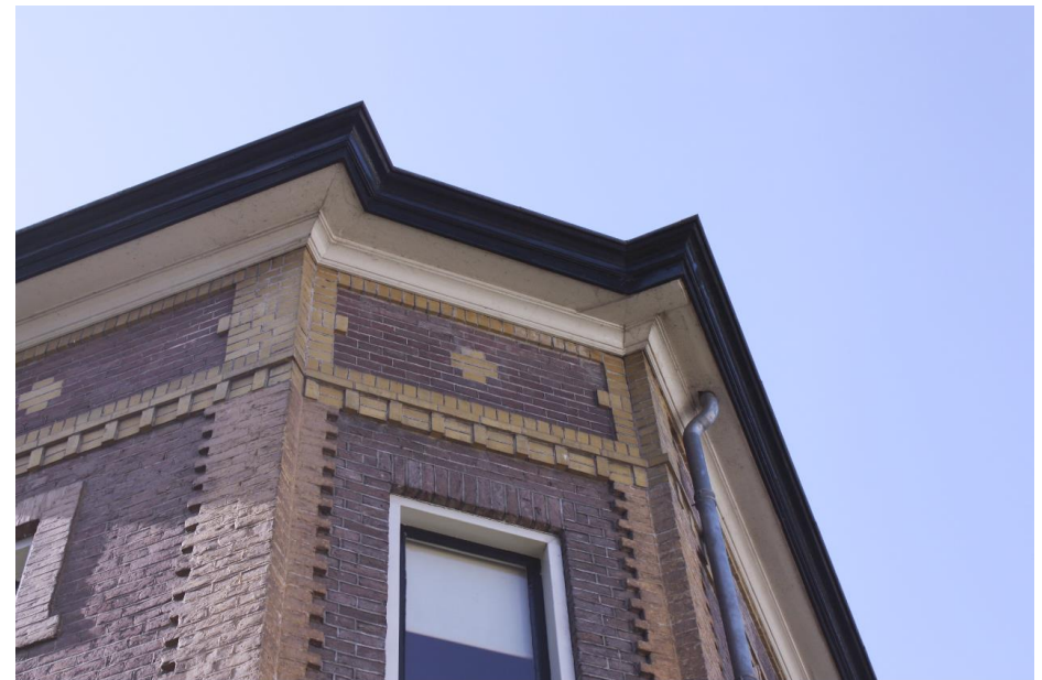
Detailopnames van de overhoekse muizentand en de in 1909 aangebrachte borstwering met de overgang in de hoekketting.
