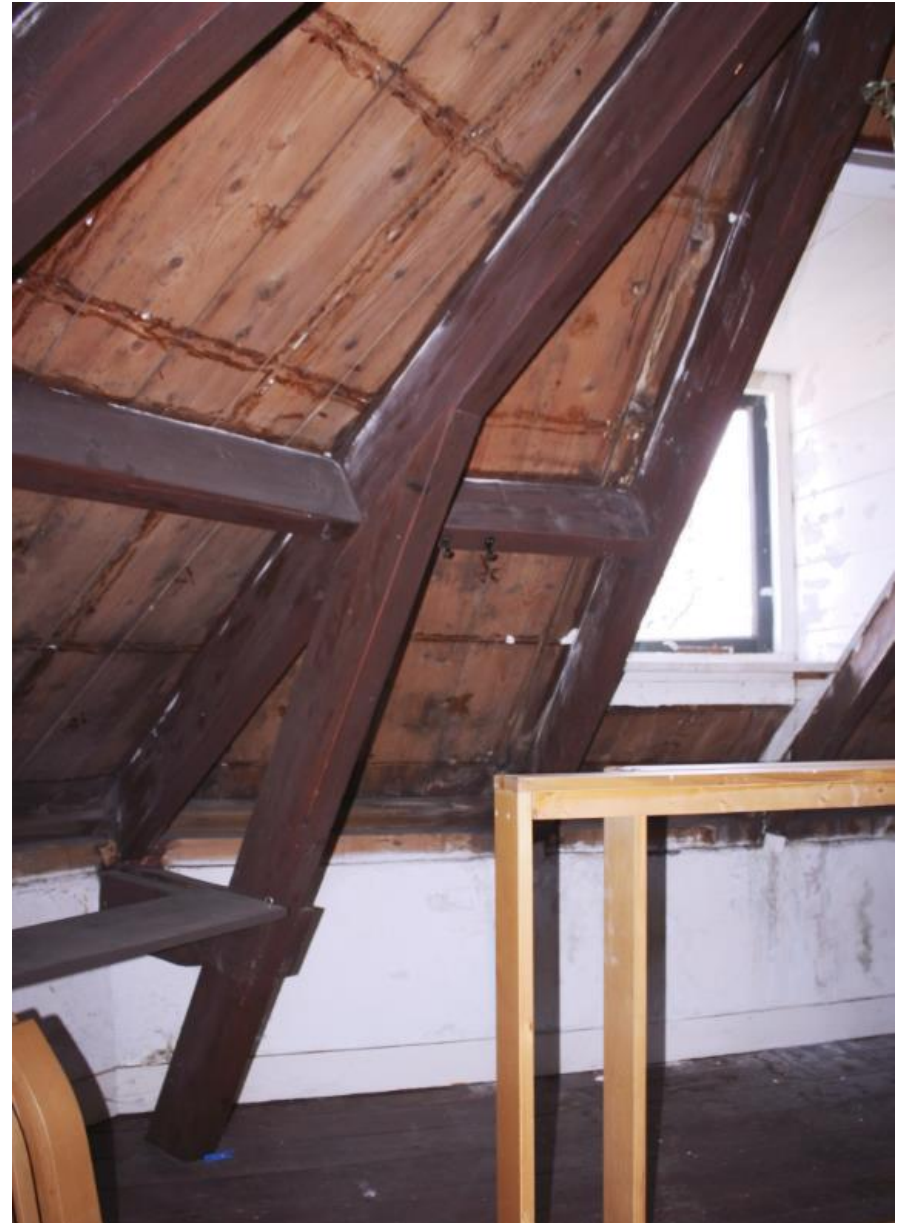
De in 1909 aangebrachte kap bestaat uit Hollandse spanten met kreupele stijlen.
