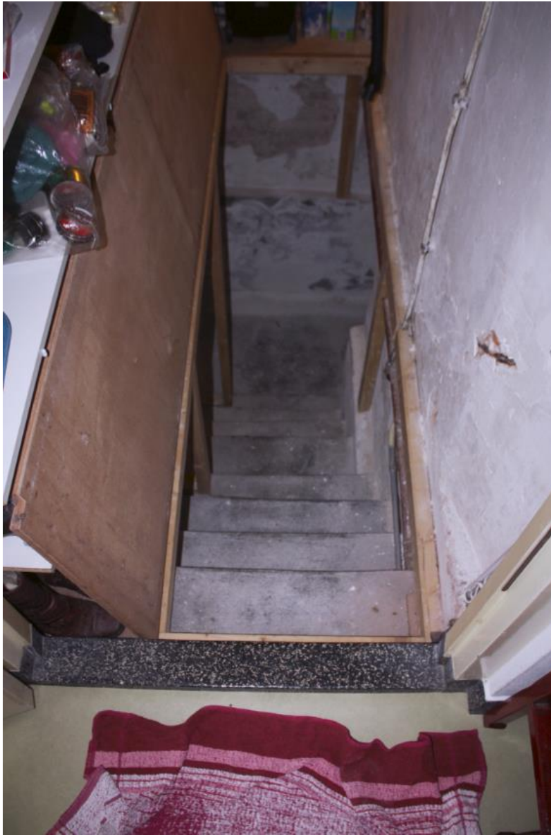
De betonnen keldertrap is wellicht in 1954 aangebracht.
