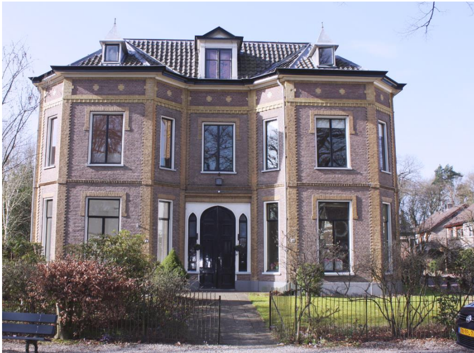
Zicht op de voorgevel.
