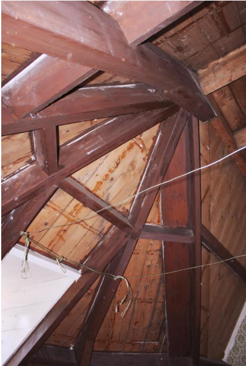
Detail van de aankapping met kepers boven de erker.
