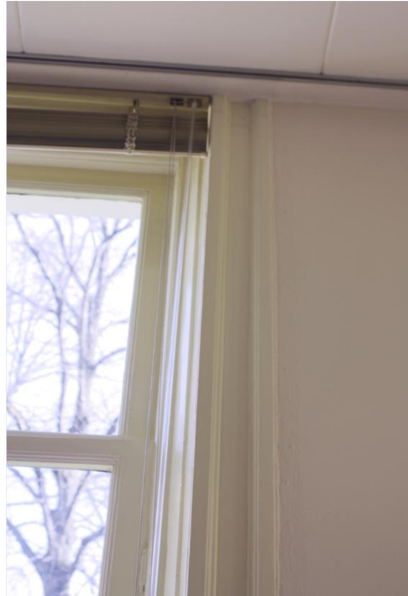
Detail van de omlijstingen bij de oorspronkelijke vensters in de voorkamer.
