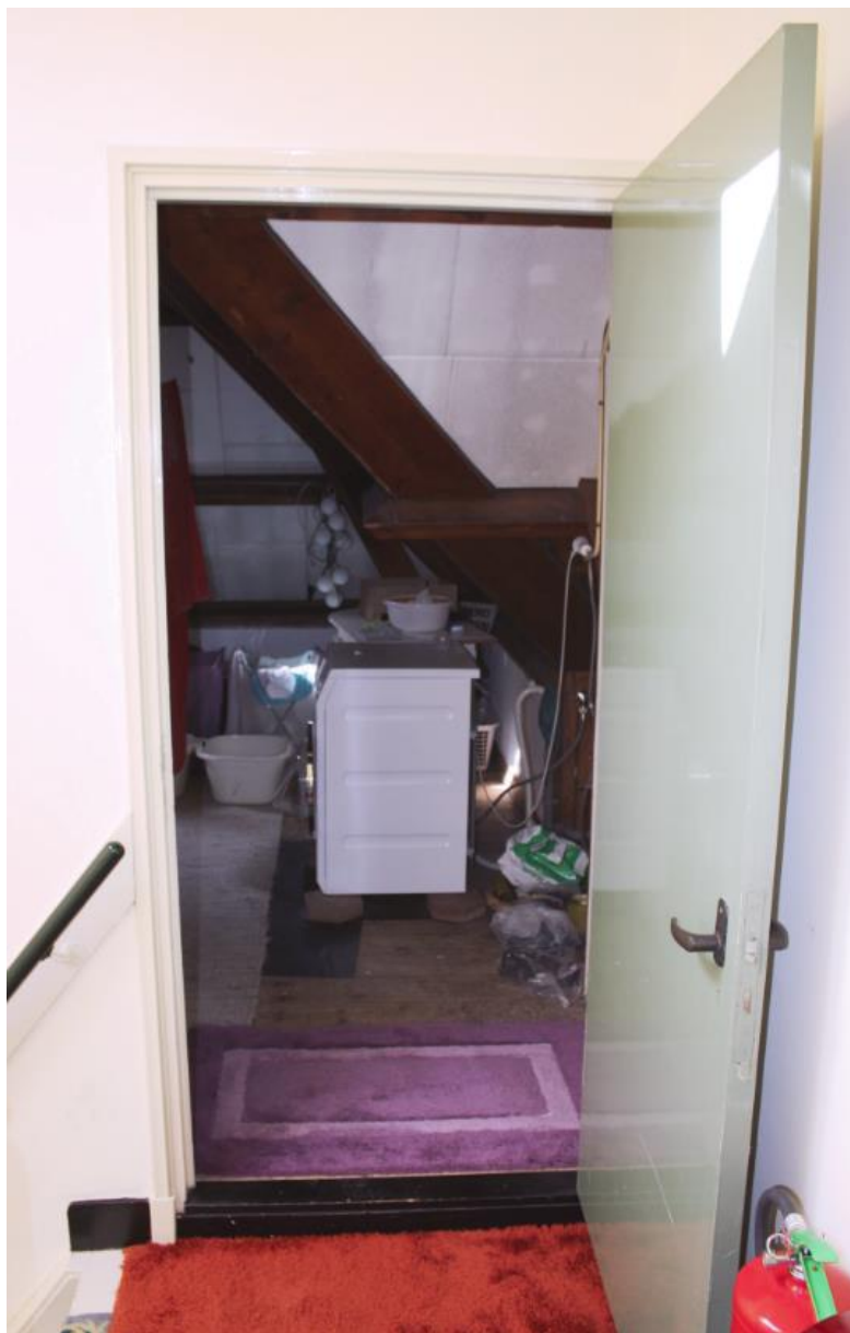
De overloop op zolder met de doorgang naar de achterkamer.
