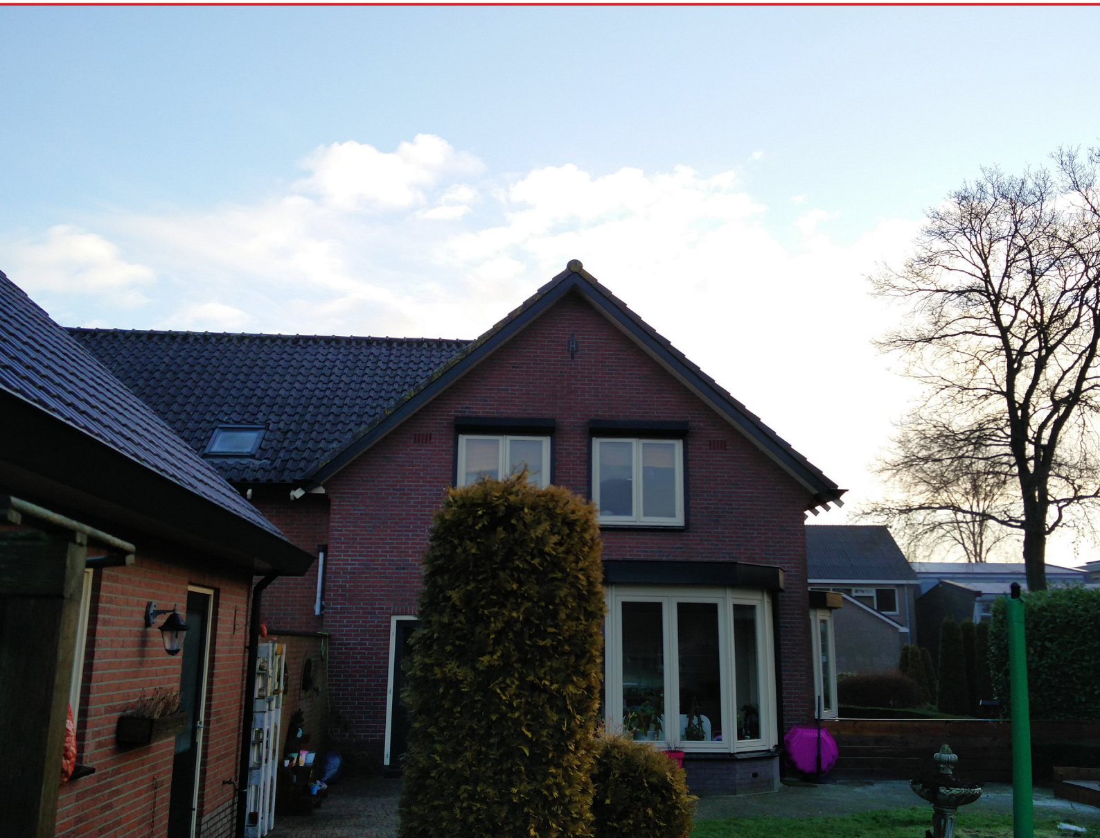
Beeldimpressie projectgebied: achterkant woning toegankelijke ventilatieroosters zijn zichtbaar.
