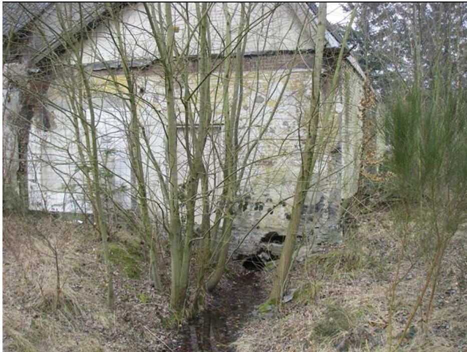
Foto B2.5 Zuidwand chemische wasserij met beekje
