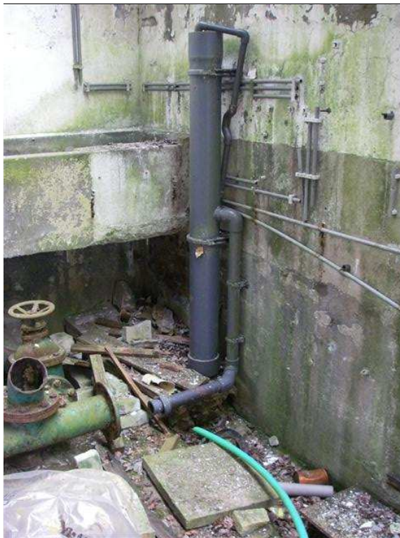
Foto B2.6 Foto genomen in de chemische wasserij
