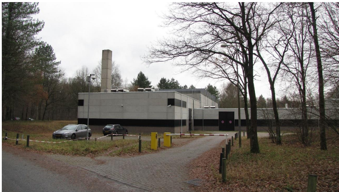
Figuur 4: zuidwestzijde van het te slopen pand
