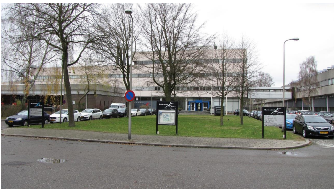
Figuur 2: zuidzijde van het te slopen pand
