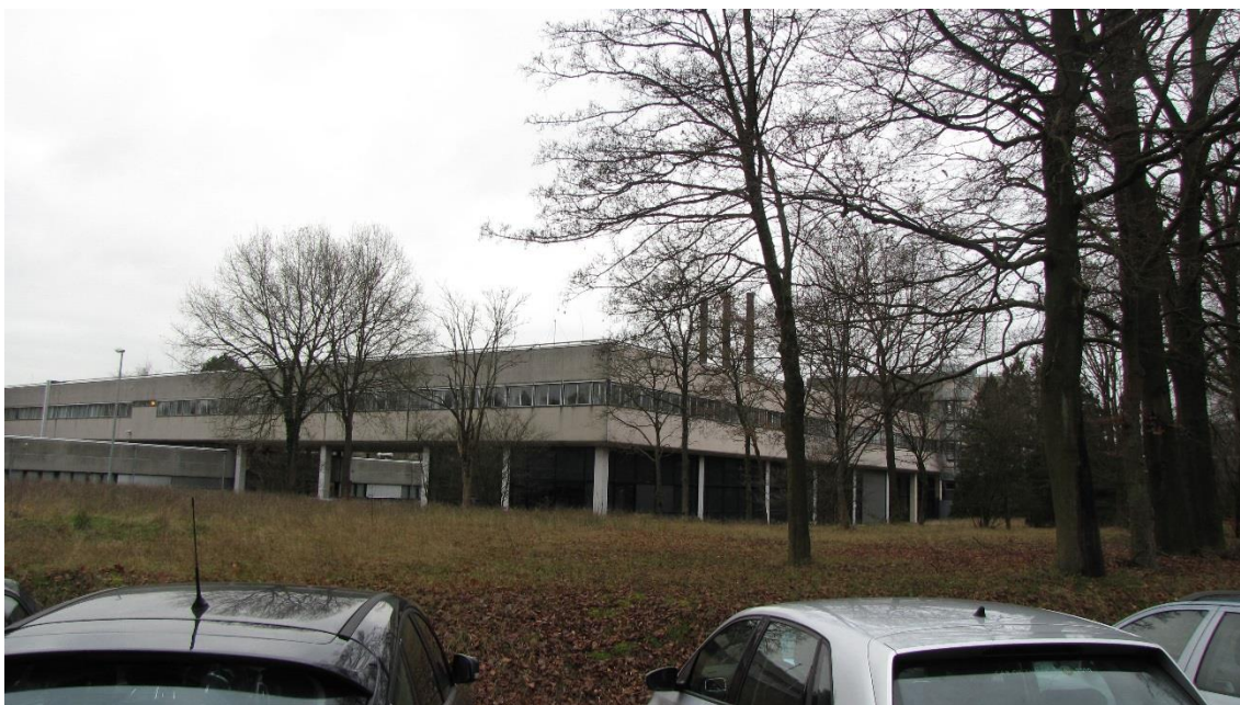
Figuur 3: westzijde van het te slopen pand
