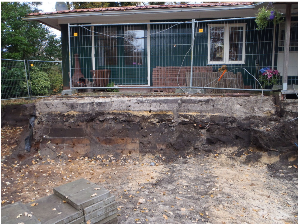
Afbeelding6 Ontgraving begrensd door chalet
