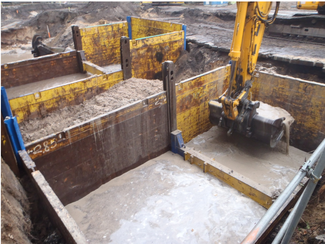
Afbeelding5 Ontgraven beneden grondwaterniveau
