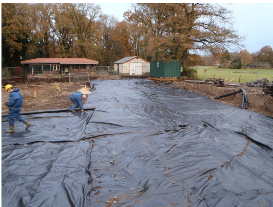
Afbeelding4 Aanbrengen worteldoek voordat wordt aangevuld met leeflaag
