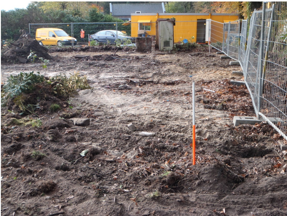
Afbeelding3 Locatie na sloop, voor start graafwerk
