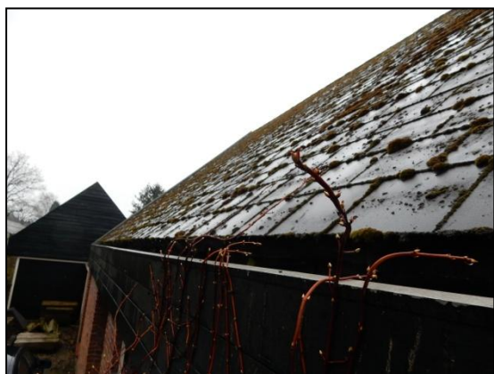
Figuur 10. Detailfoto dakopbouw.
