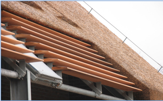
Met lamellen in het dak komt er met een lage goot voldoende licht binnen.
