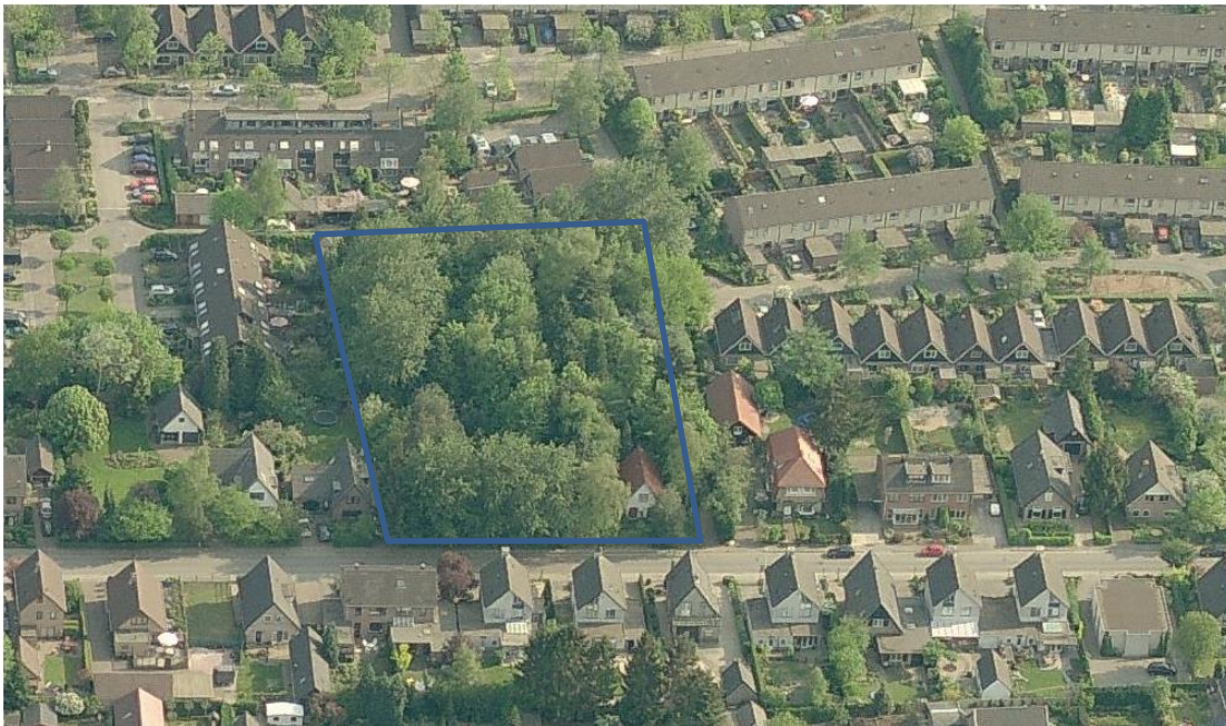
Figuur 2: Luchtfoto perceel
