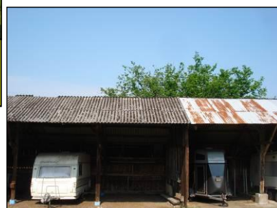
Loods: Golfplaten dak (M02AA)
