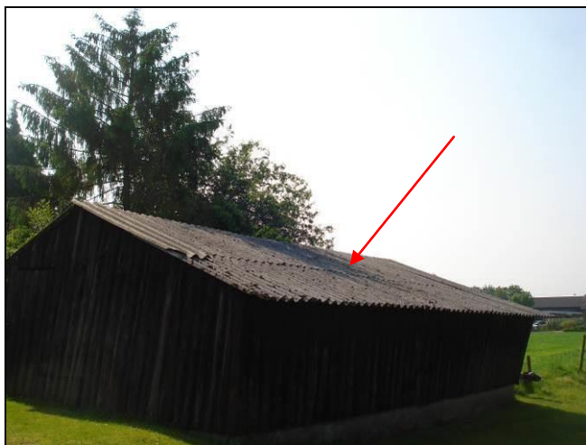
Foto 5: Kippenshuur: Golfplaten dak (M02AZ)
