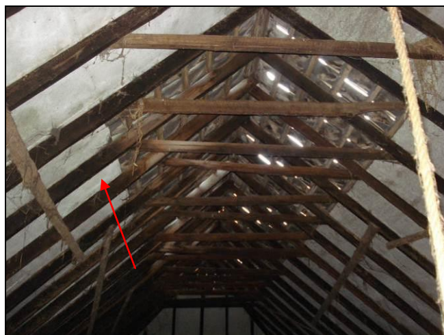
Foto 4: Woonboerderij: Achterhuis boven deel: Dakbeschoot (M01AA)
