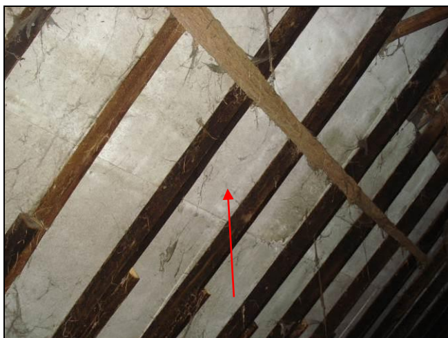
Foto 3: Woonboerderij: Achterhuis boven deel: Dakbeschoot (M01AA)
