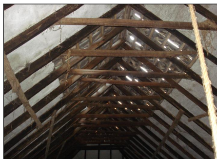
Achterhuis boven deel en gedeelte voorhuis: Dakbeschot (M01AA)
