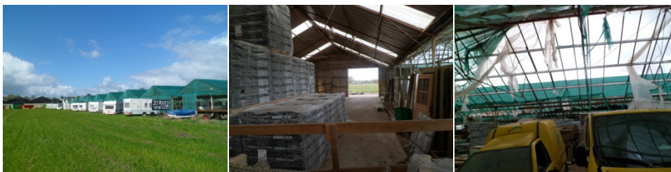
Foto's: Indrukken te amoveren caravanstalling.
