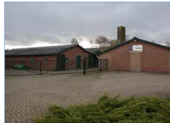
Op het erf staan verschillende varkenschuren van beperkt volume.
