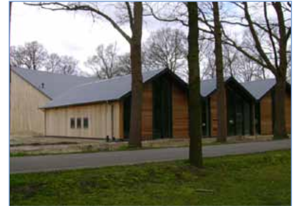
Natuurlijk kleur en materiaalgebruik. Houten gevels benadrukken ondergeschiktheid aan hoofdgebouw.
