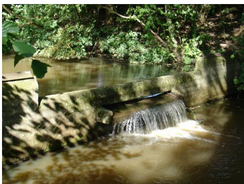
stuw in waterloop langs spoorlijn Apeldoorn-Zutphen
