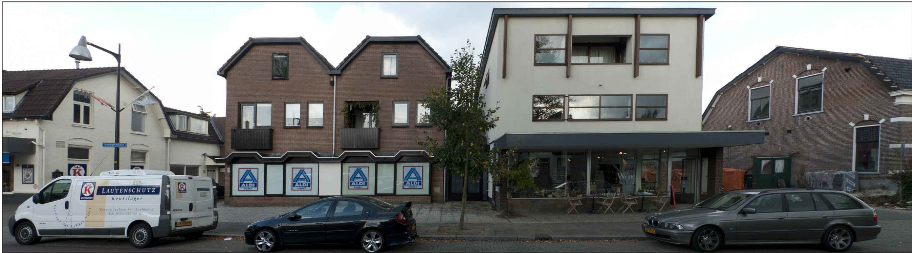
noordgevel winkels bestaand
