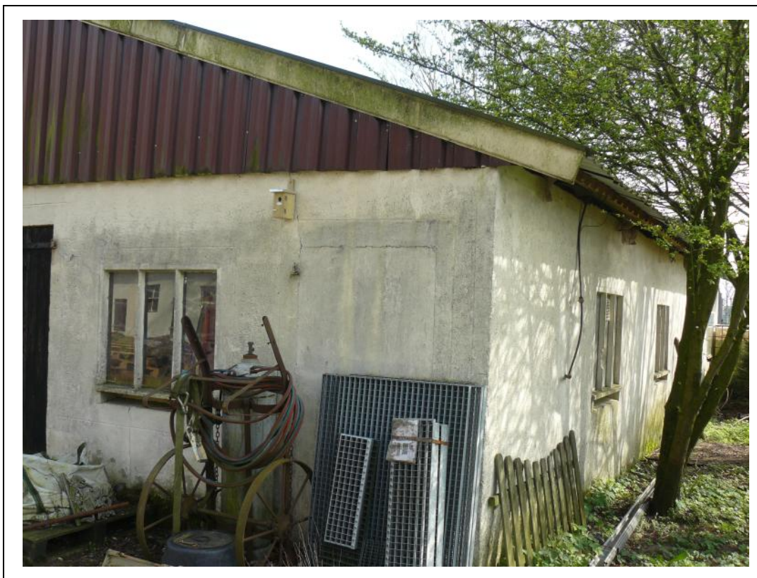
Foto 2. Noordzijde loods op onderzoekslocatie.
