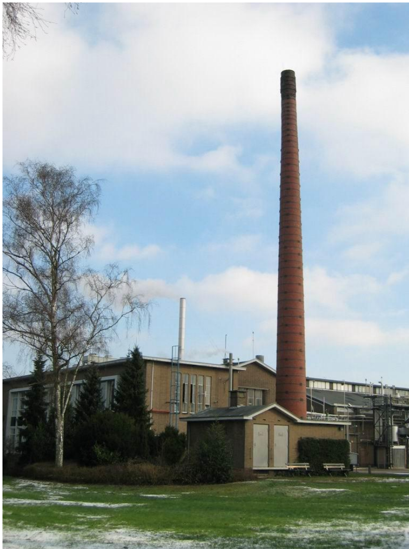
ketelhuis met schoorsteen (2), en transformatorgebouw (3)
