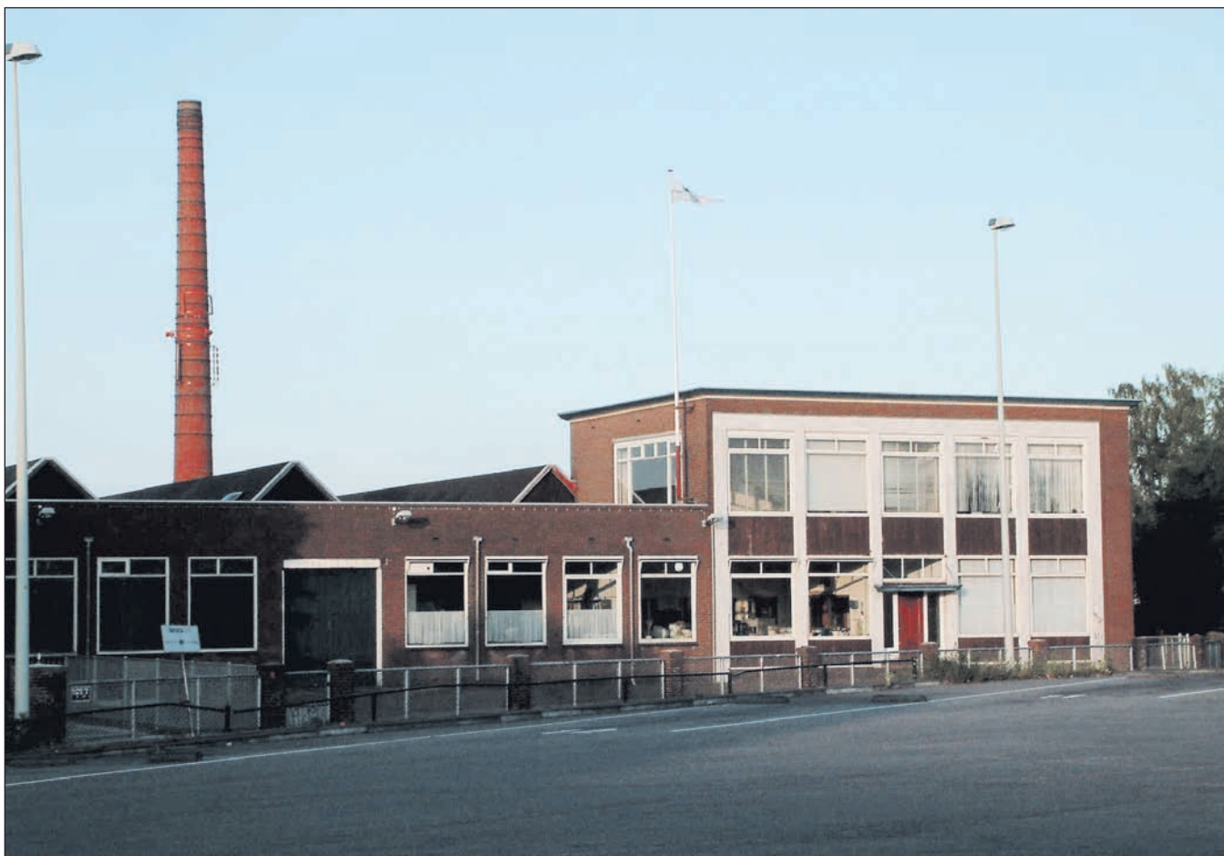
Het naoorlogse complex
