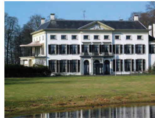
Het multifunctioneel complex als hoofdgebouw centraal
