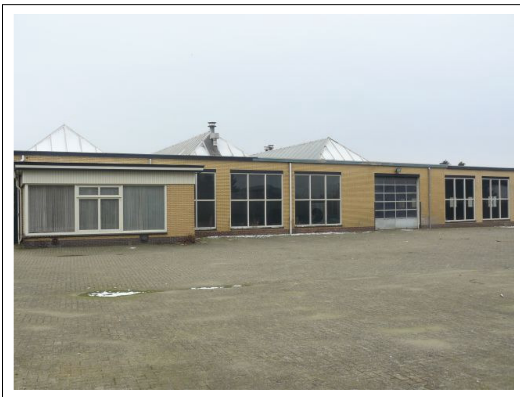
Foto 2. voormalig bedrijfspand Midap
