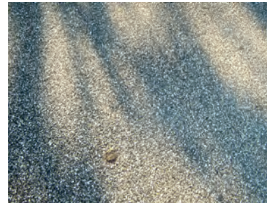
Asfalt afgestrooid met parelgrind
