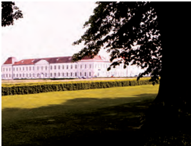
Baksteen en stucwerk
