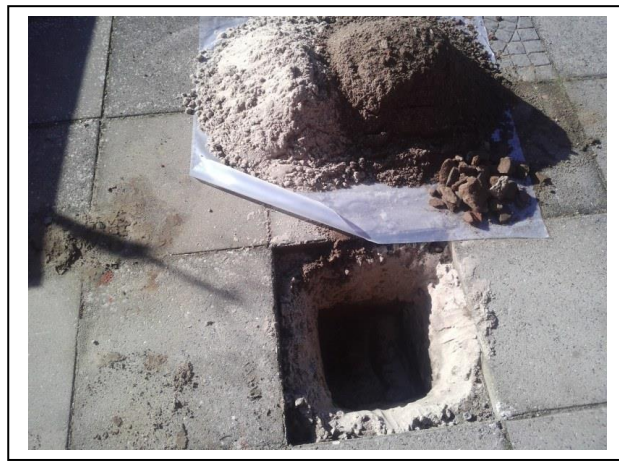
Foto 4. Opgegraven en gezeefd materiaal inspectiegat 04A
