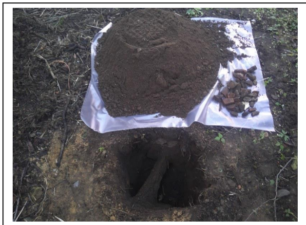
Foto 3. Opgegraven en gezeefd materiaal inspectiegat 03A
