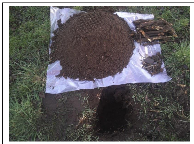
Foto 2. Opgegraven en gezeefd materiaal inspectiegat 02A
