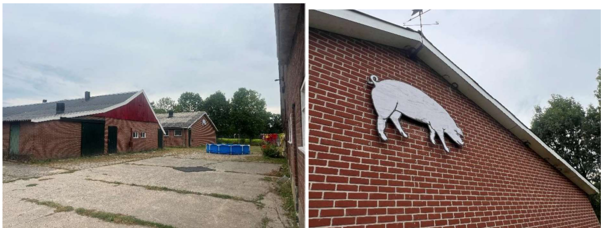
Gebouwen met bakstenen buitengevels en luchtpouw.
