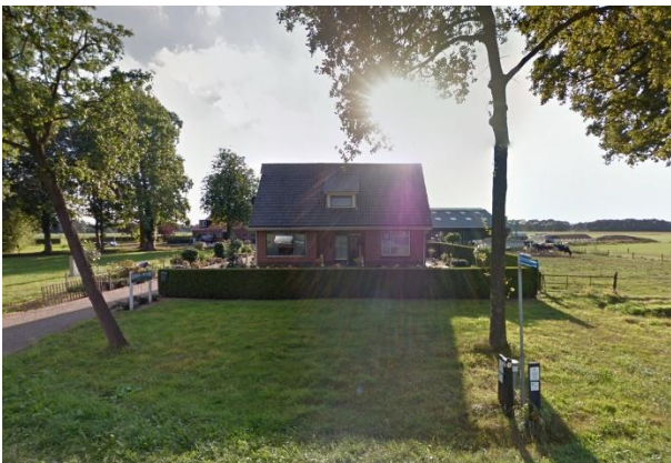
Aanzicht voorzijde van de 2 e bedrijfswoning 9a.
