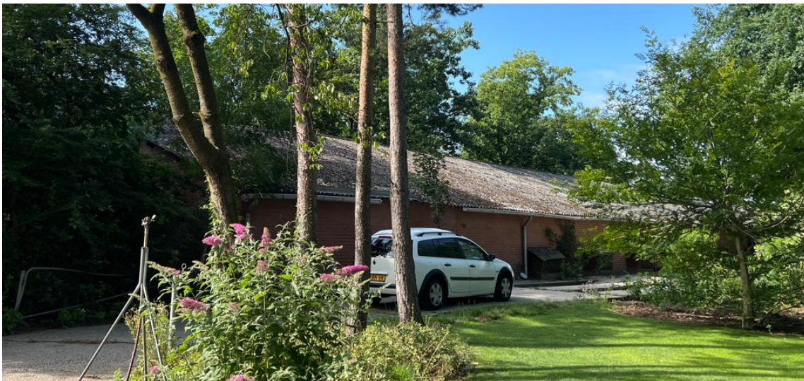
Aanzicht op de te slopen varkensstal
