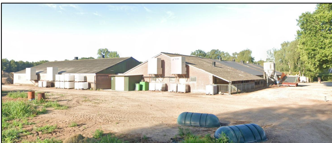
Figuur 4: Zicht op planlocatie vanaf Seinsdijk– noordoostzijde (bron: Google Maps)
