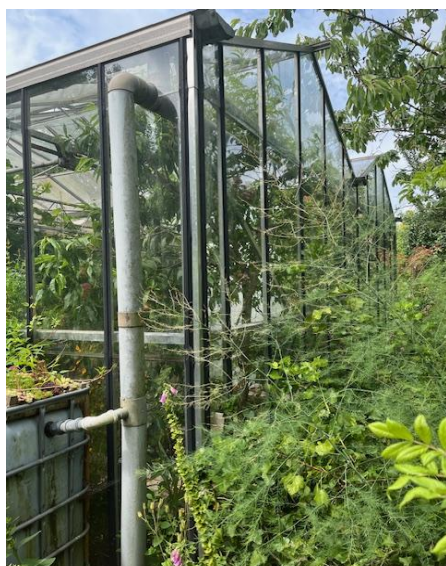
Achterkant en regenwateropvang aan de oostelijke zijde
