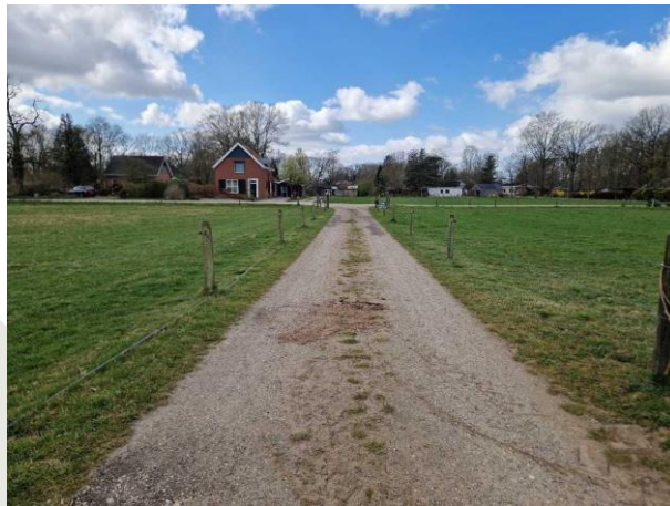
Figuur 12: Oprit met puinverharding
