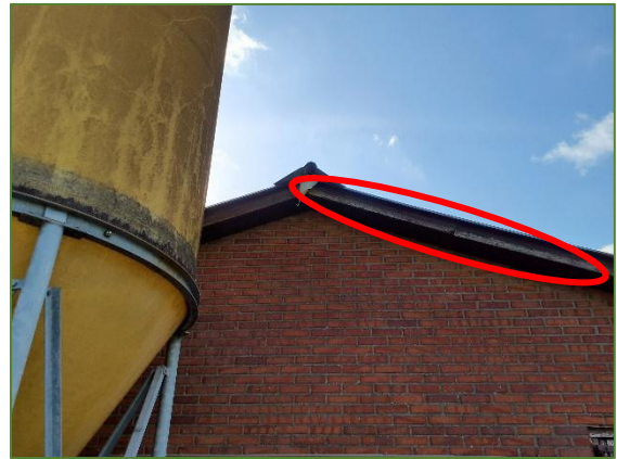
Foto 4: ruimte achter de boeidelen biedt verblijfsmogelijkheden aan vogels en vleermuizen.
