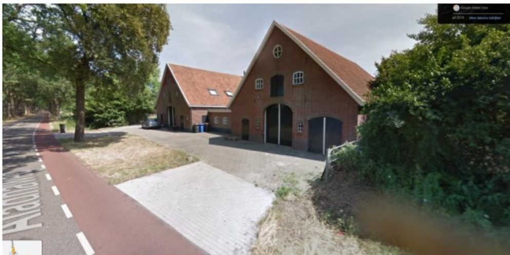
Zicht op de woonboerderij (links) en bijgebouw (rechts) vanaf de Aladnaweg in noordoostelijke richting. De nieuwe woning wordt in de rechter schuur ontwikkeld (bron foto: Google streetview).
