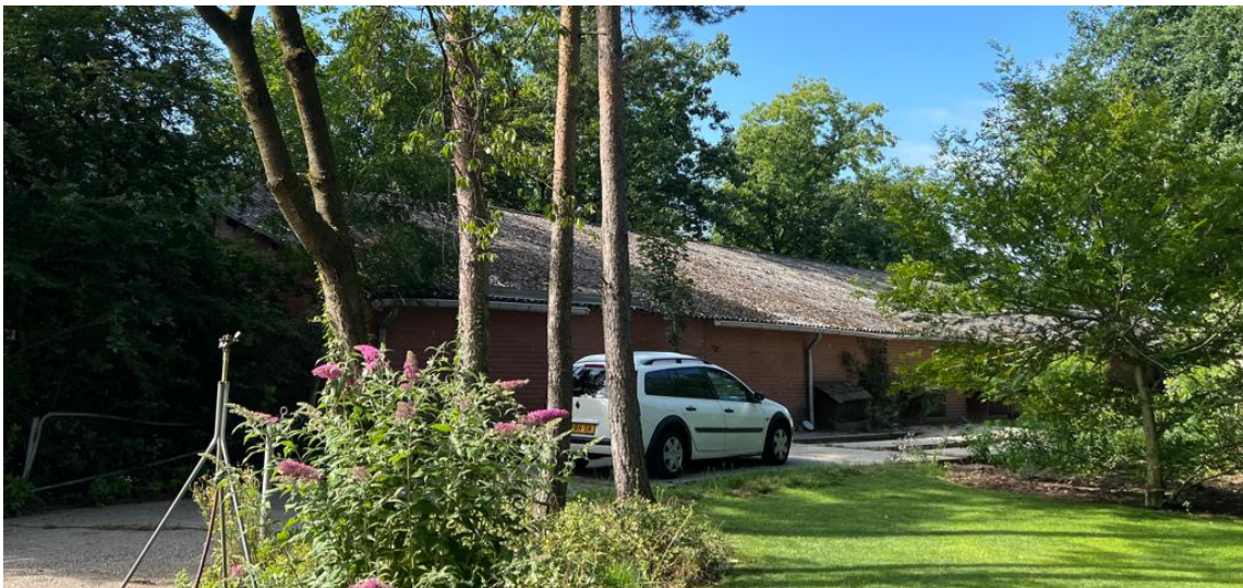
Aanzicht op de te slopen varkensstal
