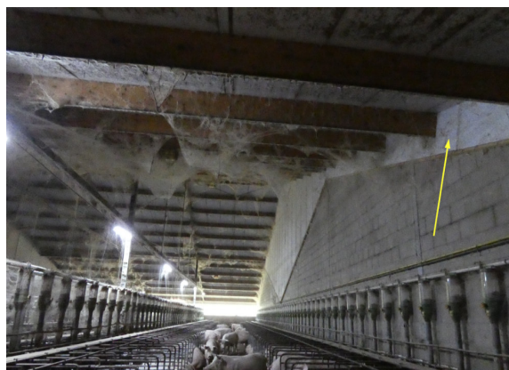
Foto 28 strakke afdichting in planlocatie 1
