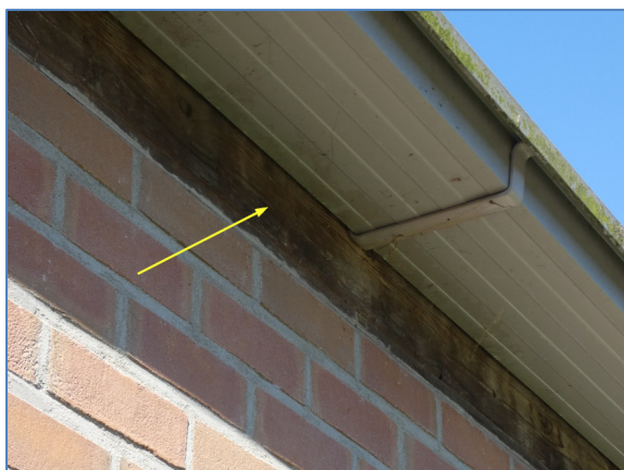
Foto 10 afdichting onder goot planlocatie 1
