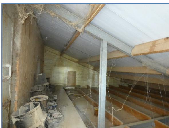
Foto 36 geheel dicht afgewerkte ruimtes N naast luchtkanaal in planlocatie 5
