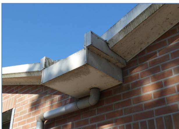
Foto 26 strakke afwerking kilgoot planlocatie 4 en 1
