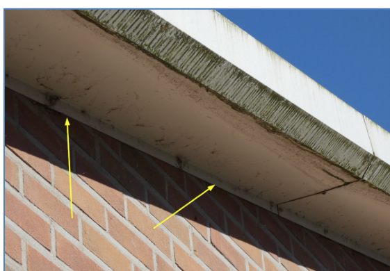
Foto 25 strakke afdichting voorgevel planlocatie 1
