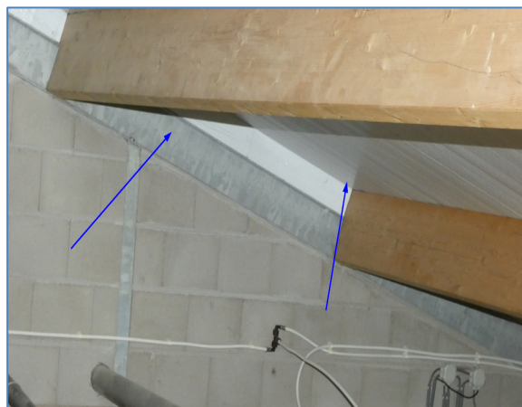
Foto 30 en 31 afdichtingen boven bezoekersruimte in planlocatie 1
