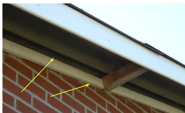
Foto 13 afdichting onder windveer planlocatie 2
