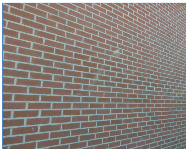
Foto 18 en 19 muren zonder open stootvoegen planlocatie 2 en 5 als voorbeeld
