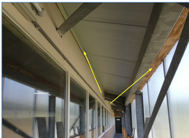
Foto 32 strak afgedichte constructie bezoekersgang planlocatie 1
