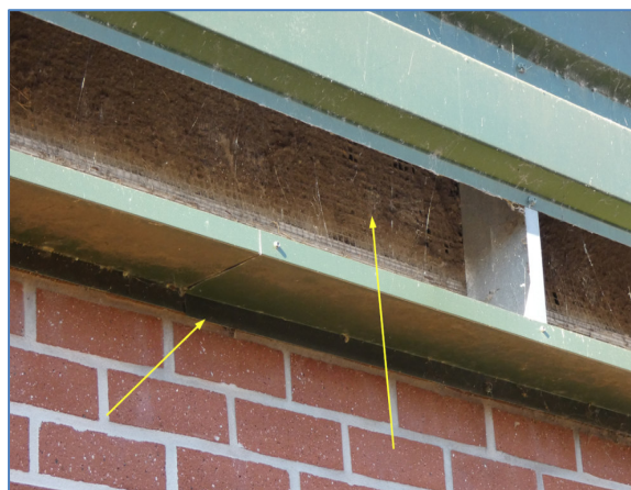
Foto 16 afdichtingen kit en gaas luchtinlaat planloc. 5
