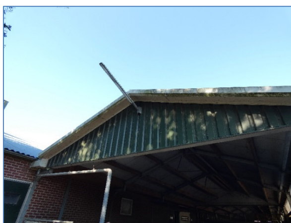
Foto 8 planlocatie 6 vanaf Oost gezien
