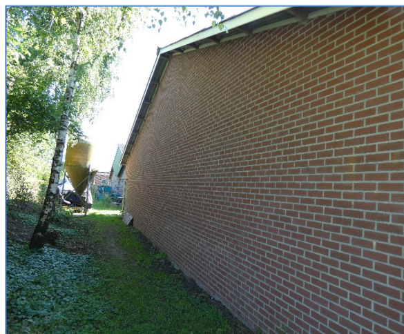
Foto 18 en 19 muren zonder open stootvoegen planlocatie 2 en 5 als voorbeeld
