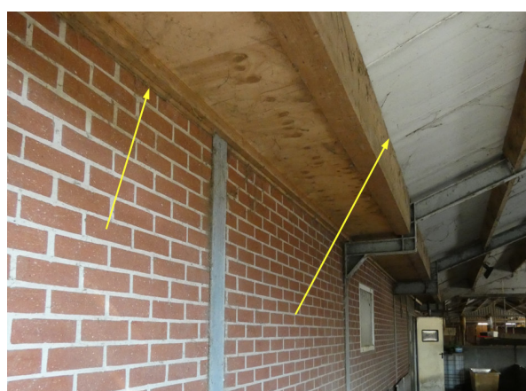
Foto 23 afgedichte constructie planlocatie 6 aan 5
