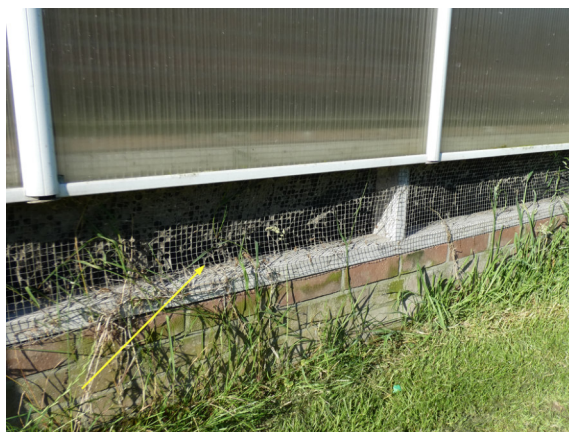
Foto 11 gaas-afdichting onder bezoekersgang
