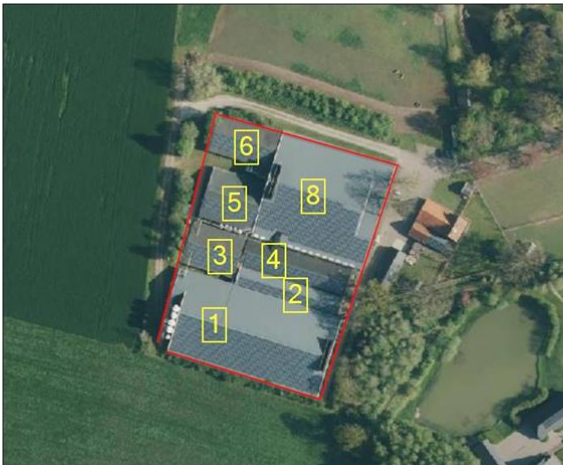
Figuur 2 Luchtfoto huidige situatie met in geel aanduiding betreffende te slopen gebouwen.
