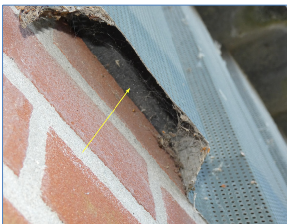
Foto 33 afgedichte geperforeerde plaat planlocatie 3
