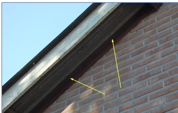
Foto 24 afdichting windveren voorgevel planloc 7
