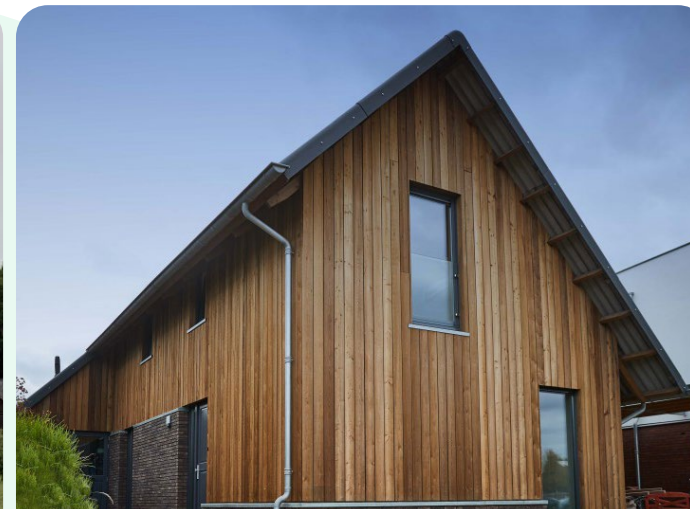
Kapschuur rij-woningen met hoge goot aan erfzijde
