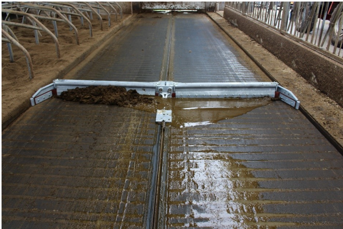
De vloer in een loopgang, met halverwege een mestschuif
