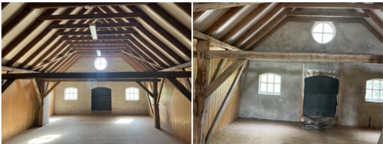
Foto's van de zolder van de te verbouwen schuur.
