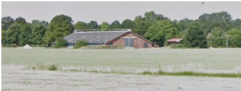
De ligboxenstal is zichtbaar vanaf de Neethweg.
